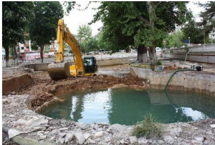
Şekil 5.Kernek Şelalesi Bakım ve Onarım Çalışması
